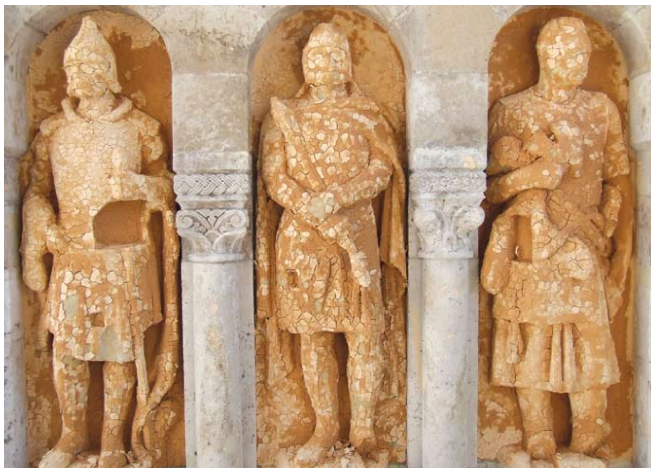
Sótalanítás – jobbra fent jól láthatók a kivált sókristályok
